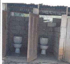
Foto 6: MODULO IV Sustitucion de inodoro y sustitucion de dos accesorios para sanitario mas adaptador macho pvc 1/2
