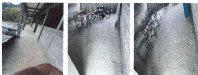
Foto 5: MODULO III Sustitucion de piso de cemento líquido por piso de granito pasillo, aula 1 y aula 2
